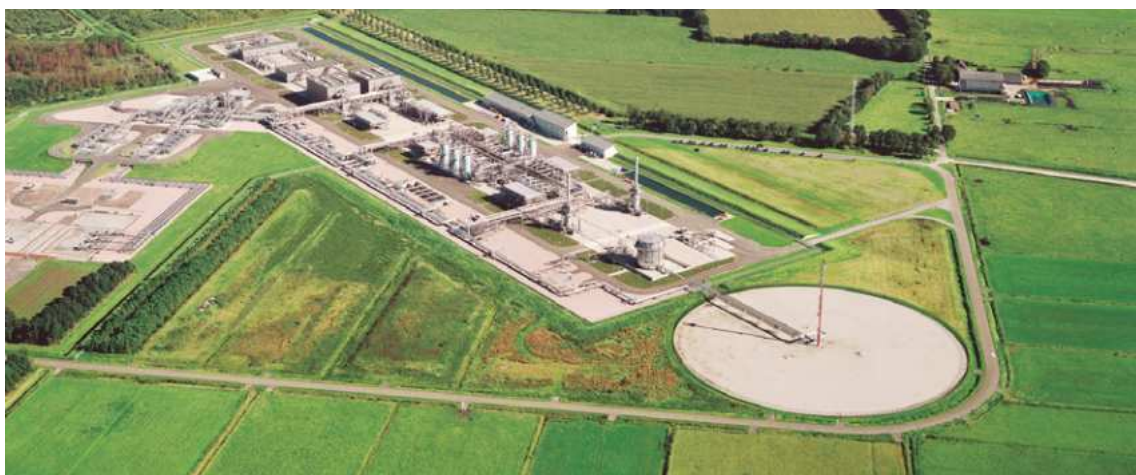
Langelo - Gasopslag - realisatie in 2020 (Beeld: HOSPER, 2020)
