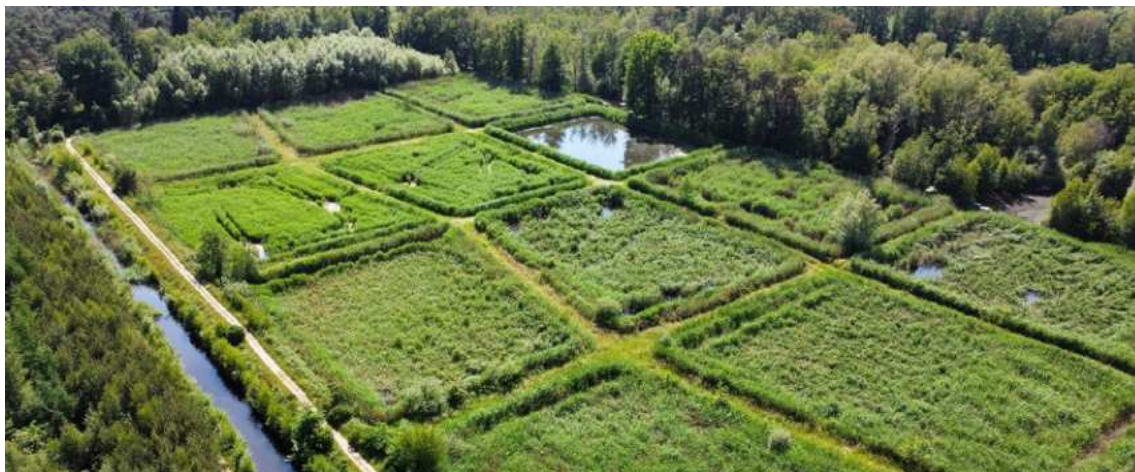
Haaksbergen - waterpark Lankheet - realisatie in 1999 (Beeld: Strootman, 2007). Een systeem van rietbassins dient als helofytenfilter dat onder andere fosfaat en stikstof uit het aangevoerde water filtert.
